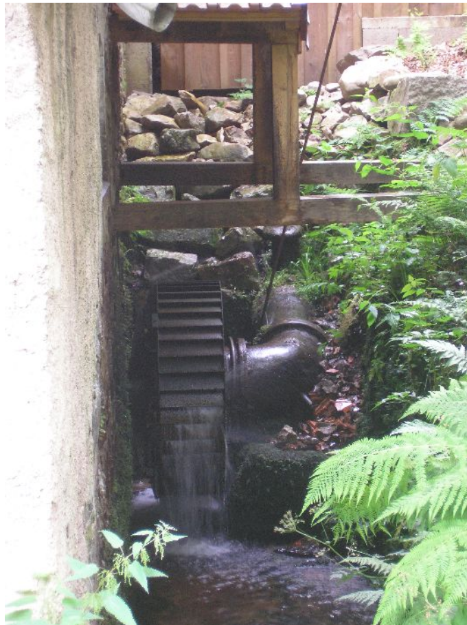
Figure 1. Turbine à l'arrêt et conduite forcée
